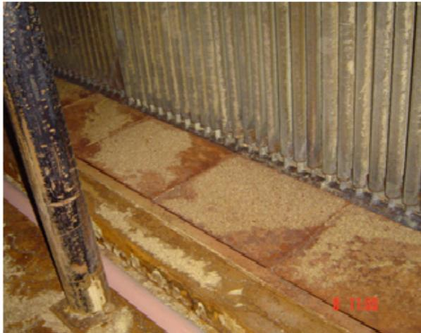
Depósitos sulfurosos en tubos del economizador
