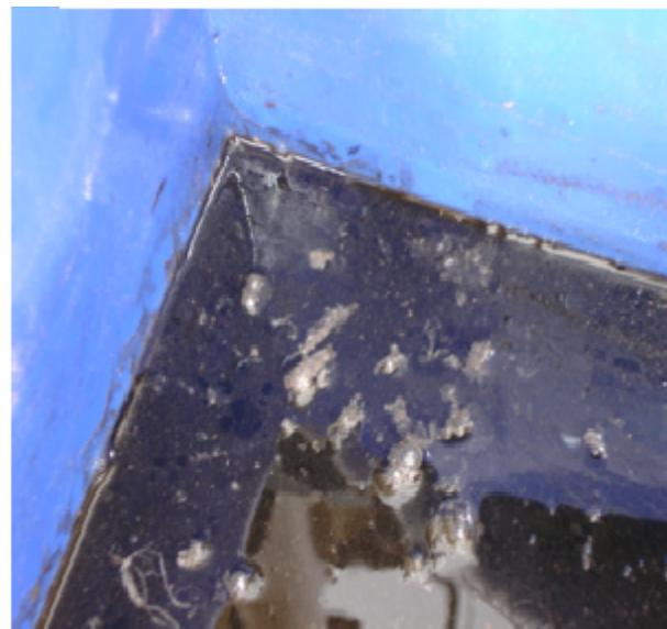
30 de Septiembre de 2006. Al drenar la trampa colectora se observa un líquido de consistencia viscosa, de color oscuro y con un fuerte olor a hidrocarburos
